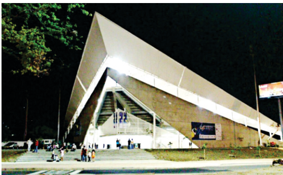
Estadio de Softball / Cali
